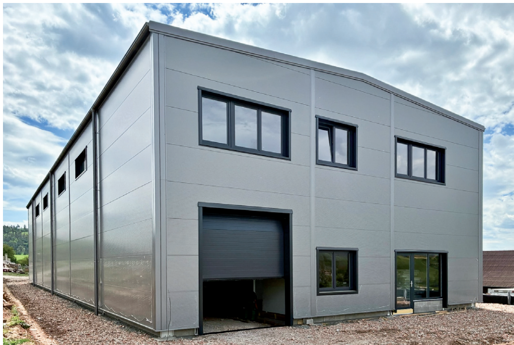
Administrativně skladová hala v Malhostovicích u Brna
